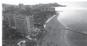
露出オーバー (+1/2)
