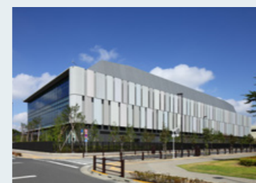
西東京データセンター1号棟
