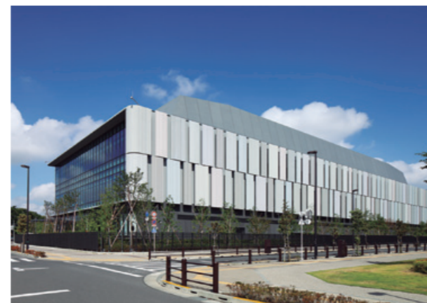
2012年 西東京データセンター稼働
