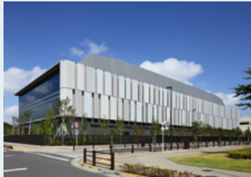
西東京データセンター1号棟
