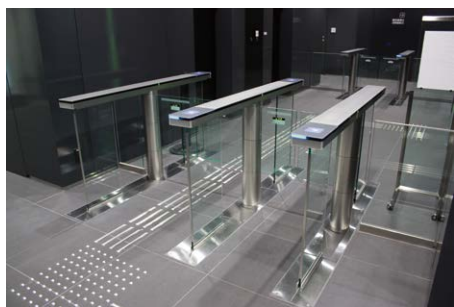
港南事業所のフラッパーゲート
