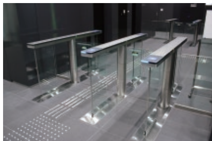
港南事業所のフラッパーゲート
