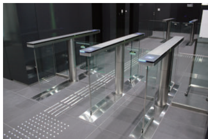
港南事業所のフラッパーゲート
