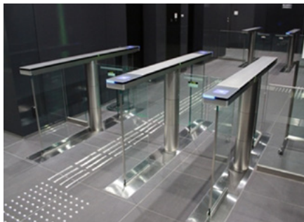
港南事業所のフラッパーゲート
