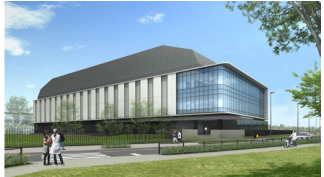
西東京データセンター
