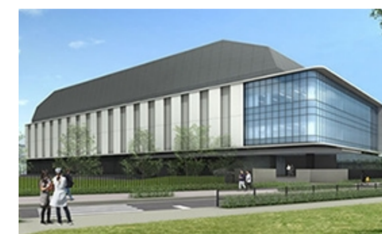
西東京データセンター外観
