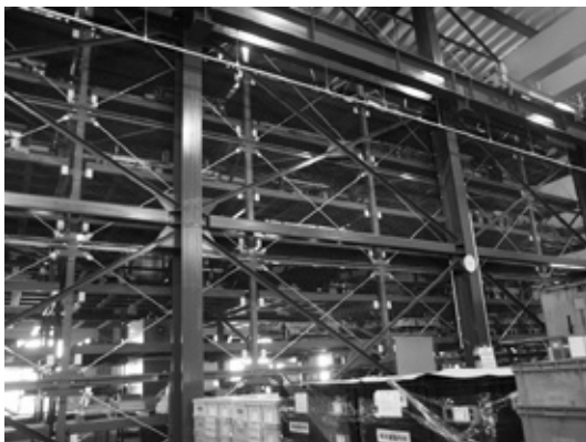
写真3 金型を集約することで、各工場から金型運搬用のフォークリフトを排除することも可能に
