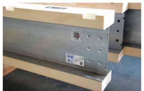
作業指示ラベルが貼り付けられた「テクノビーム」部材同士の組み合わせ方や接合する金具の種類などが一目瞭然と分かる。
