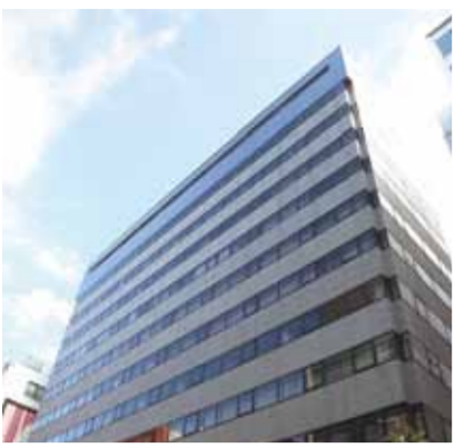
日本通運東京支店
