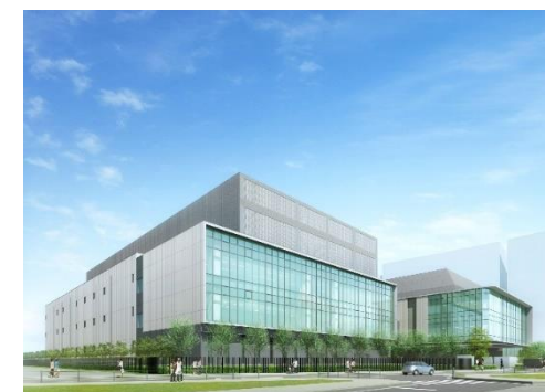
西東京データセンター
